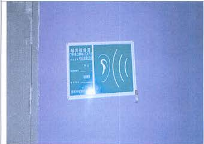
风机房 8 噪声标志牌
